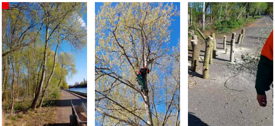
Baumarbeiten am Tiefstackkanal
