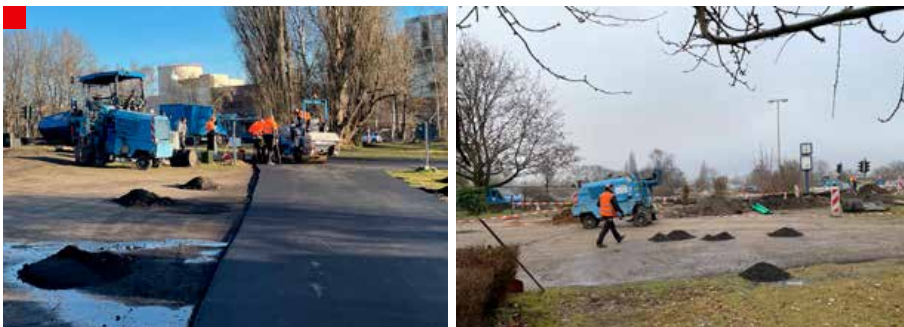
Umfangreiche Asphaltierungsarbeiten vor der Geschäftsstelle
