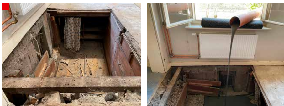
Anfang April wurde der Kriechkeller freigelegt und versiegelt.
