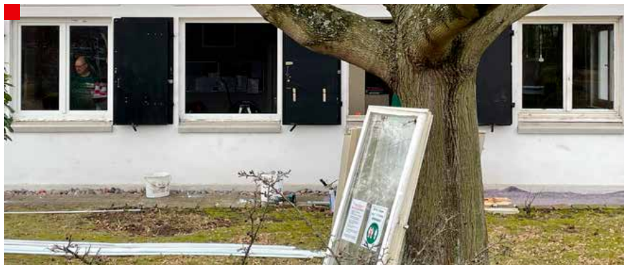
Austausch der alten Fenster in der Geschäftsstelle
