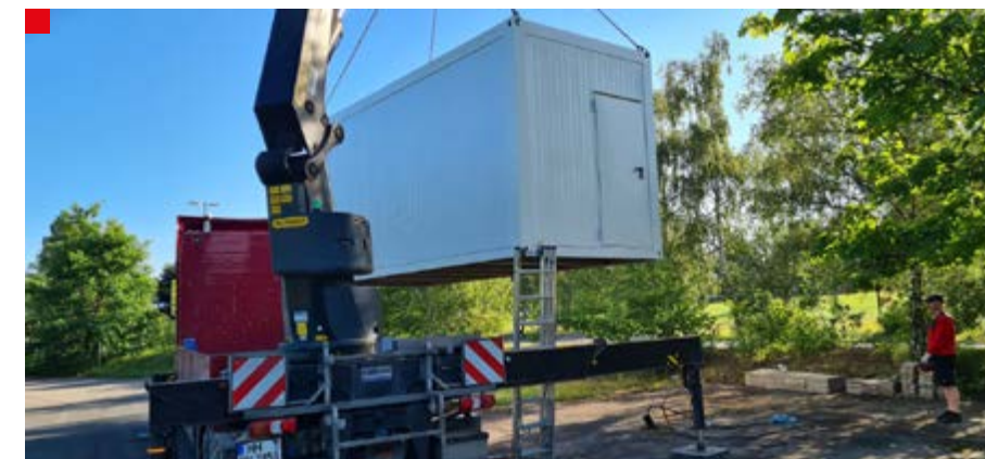
Der neue Lagercontainer wurde per Kran an seinen Standort gebracht.
